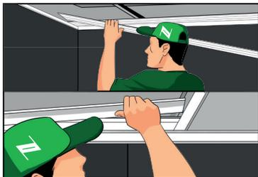
**07** A lâmina deve ser fixada nos elementos de armação, através da aba. Para a fixação use preferencialmente parafuso agulha.
